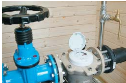
Der geöffnete Deckel gibt den Blick frei: Gestern Nachmittag zeigt die Wasseruhr hinter der Pumpe eine Fördermenge von 8.997 Kubikmeter an, die seit dem 20. Februar aus etwa 27 Metern Tiefe gefördert worden sind.
